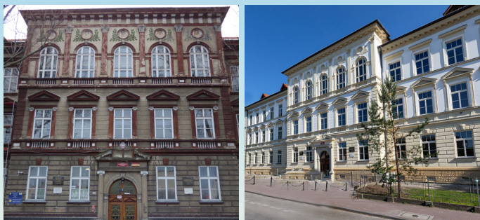
Budynek szkoły przed termomodernizacją.
